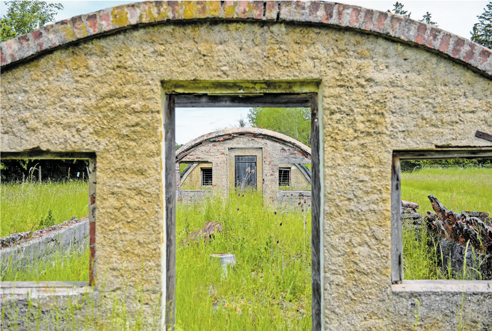
Im Lager Kaufering VII stehen auf einem Teil des ehemaligen KZ noch drei intakte Häftlingshütten mit Tonröhrengewölben.
