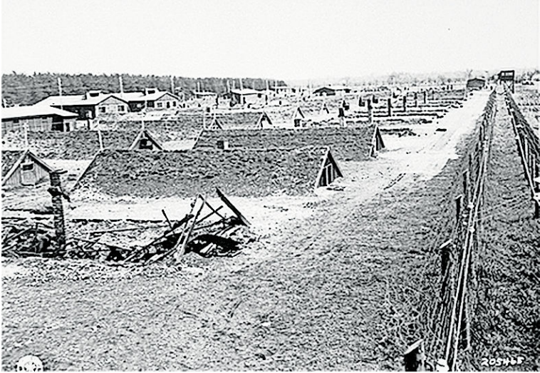
Diese Aufnahme der Erdbaracken entstand wenige Tage nach der Befreiung durch die US-Armee im April 1945.
